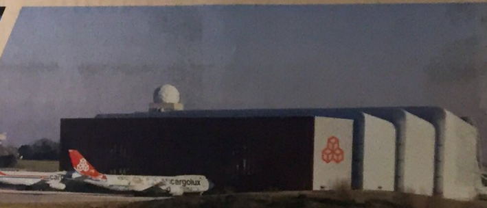
Der Hangar der Cargolux ist zum inoffiziellen Wahrzeichen von Sandweiler geworden
